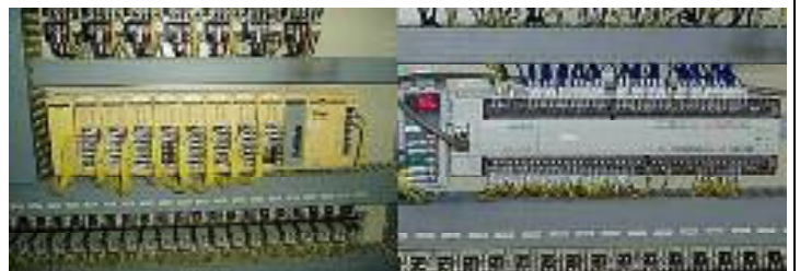
画像は弊社施工のPLC更新例(光洋>三菱)
